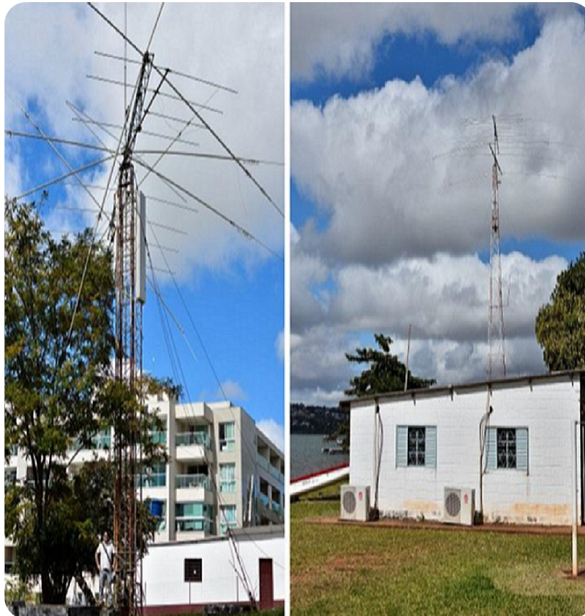
Fotografía 10: Antena Yagi Tribanda de HF de la LABRE DF (Liga de Amadores Brasileiros de Rádio Emissão - Estadual do Distrito Federal)
